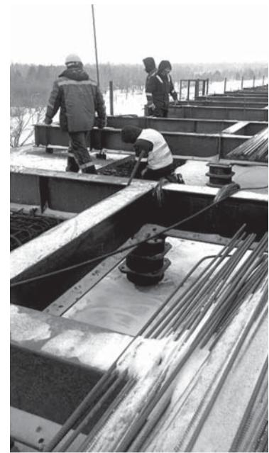
Сейчас строители заняты в основном монтажом тротуарных консолей на второй половине моста, из 70 штук смонтированы на данный момент 46, а также бетонированием пролётов, два уже тоже готовы. Эти работы будут закончены соответственно в феврале и апреле.
